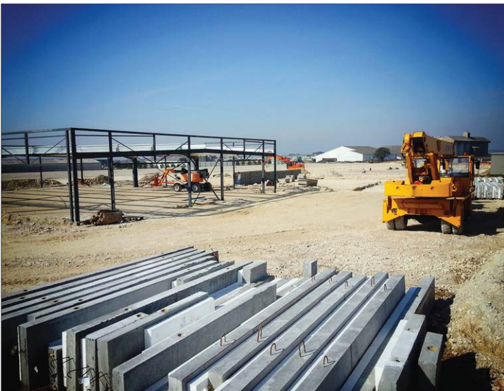
Le chantier du retail-park s'est accéléré depuis janvier. Les deux bâtiments auront une surface totale de 11 000 m 2 . PHOTO O. S.
